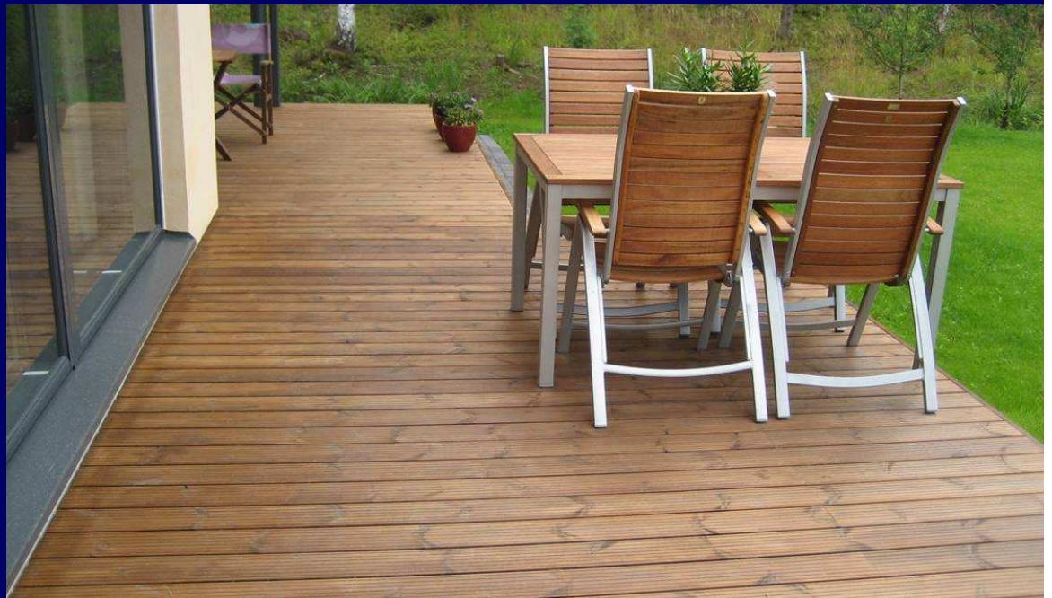
El tratamiento consiste en la introducción de la madera en una cámara especial en una atmósfera inerte, sin oxígeno y se somete a temperaturas de 240° a 260° durante períodos de tiempo de 8 a 72 horas, en función de la especie, las dimensiones de las piezas y propiedades deseadas para la madera termotratada.
