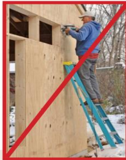
Escalera estándar usada en una configuración no aprobada
