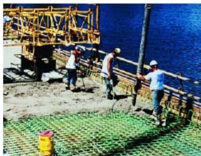
Fig. 6-6. El concreto con baja relación agua-cemento y baja permeabilidad a los cloruros, ideal para el tablero de puentes, se produce fácilmente con reductores de agua de alto rango. (69924)
