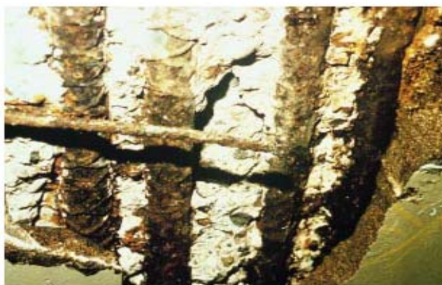
Fig. 6-16. Los daños en esta estructura de aparcamiento en concreto son resultado de la corrosión de la armadura, inducida por cloruros. (50051)
