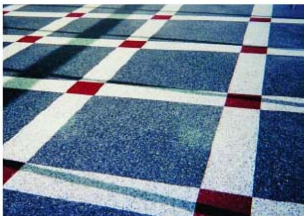
Fig. 6-19. Se emplearon pigmentos rojos y azules para colorir este piso de terrazo. (69873)
