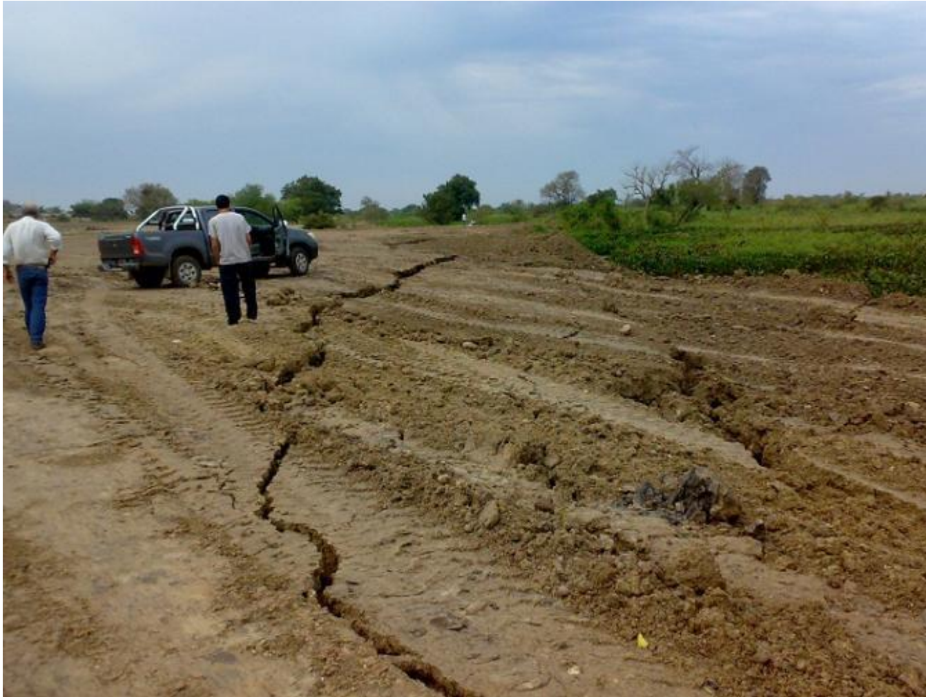
Fisura en Coronamiento
