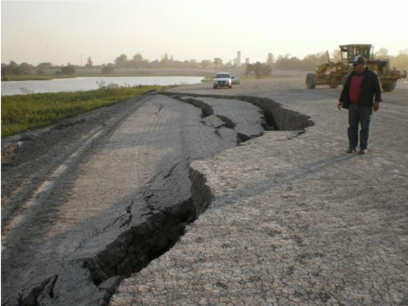
Fisura en Coronamiento
