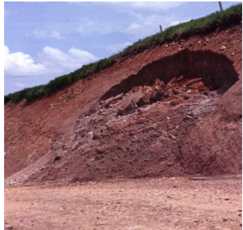
Deslizamiento en Talud Excavado
