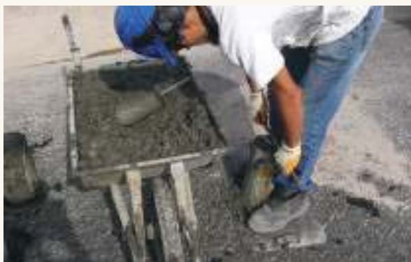
➤ Enrase superior y remoción de hormigón sobrante
