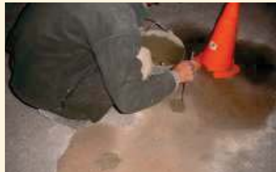
➤ Reparación de huecos dejado por testigos con grout cementicio.
