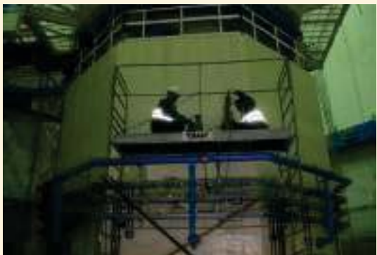
➤ Extracción de testigos con andamios y medidas de seguridad adecuadas.
