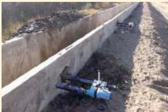
➤ Dos máquinas en serie para la extracción de testigos en canal.
