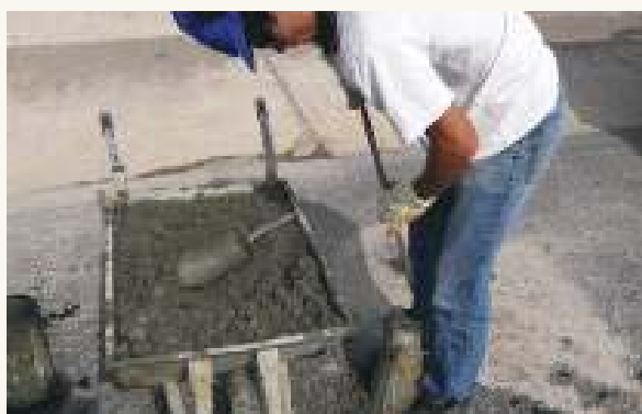
➤ Compactación de la última capa (hormigón sobrante parte superior)
