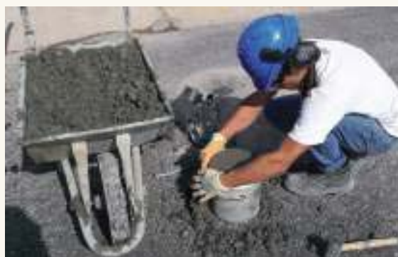
Limpieza final de los bordes y restos de hormigón
