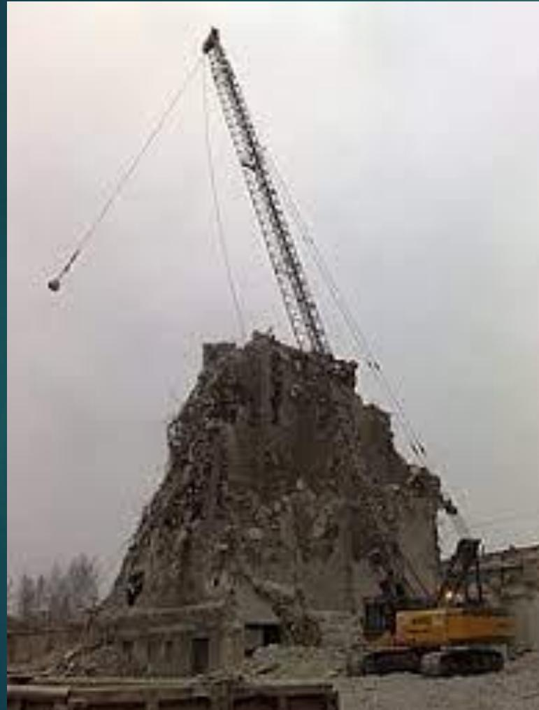
Tiene la desventaja de ser un **método no controlado**, lo cual es inevitable la voladura de grandes fragmentos de material. Solo vale la pena usar esta forma de demoler si es para un gran volumen de derribo debido al costo y dimensiones de maquinaria
