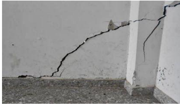
Fisuras en mampostería por asentamientos
