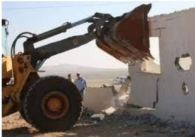
Demolición con mediante tracción
