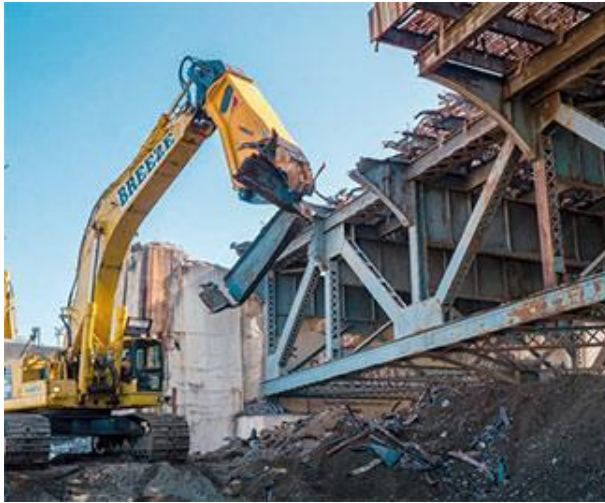
Demolición con cizalla hidráulica en estructuras metálicas
