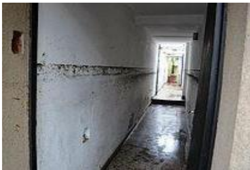
Marca de la altura de agua a la que llegó la inundación en la vivienda
