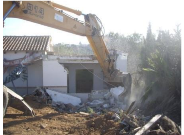
Demolición con mediante tracción
