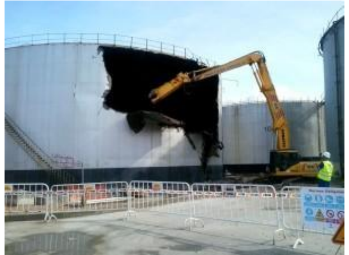
Demolición con cizalla hidráulica en estructuras metálicas
