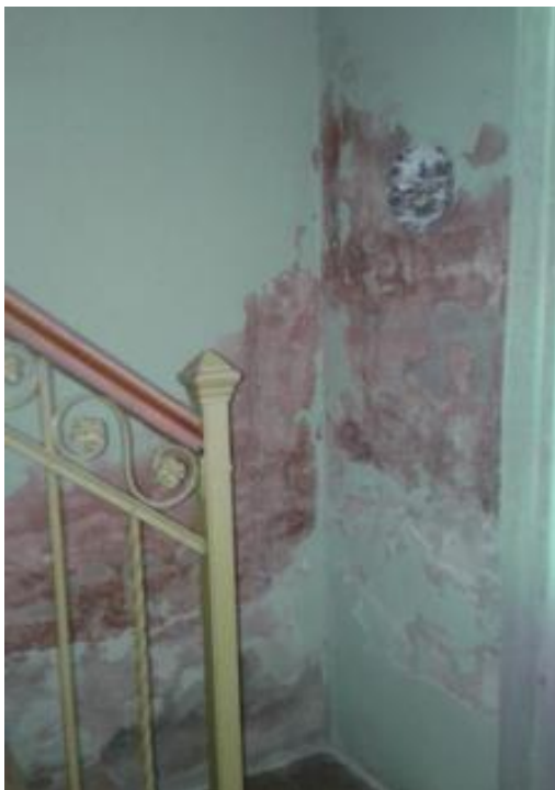
Humedades en techos y cimientos, con desprendimientos de revoque
