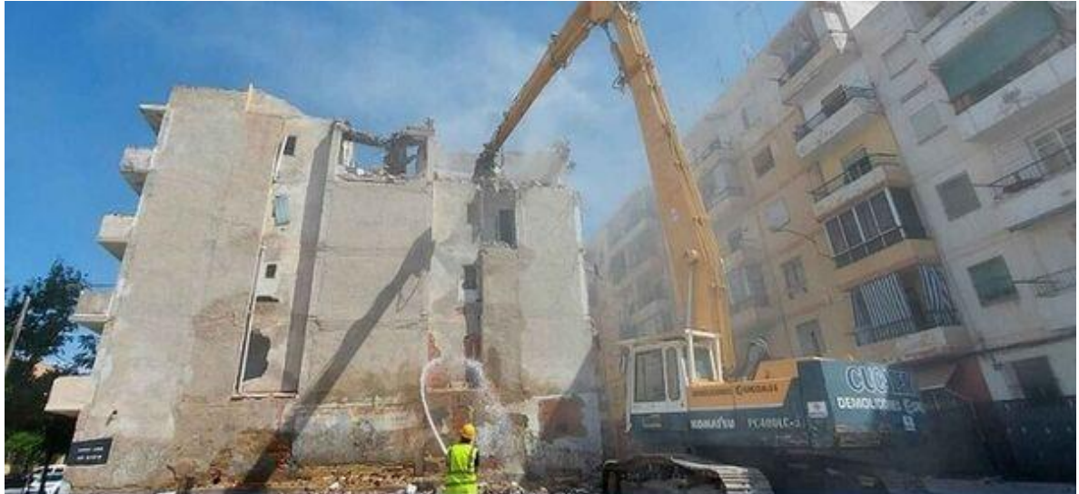
Demolición mecánica de arriba hacia abajo
