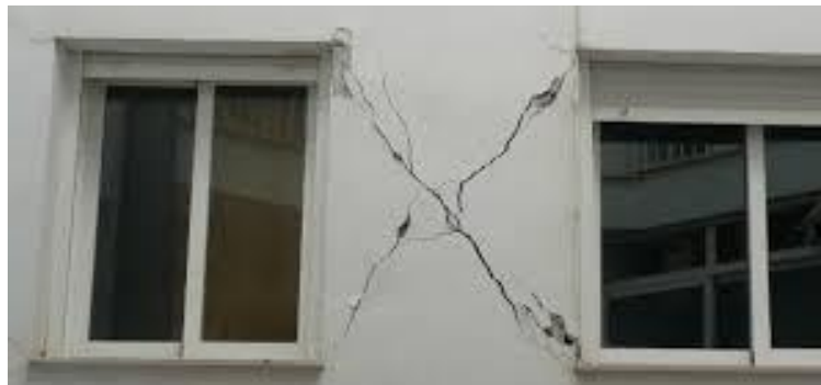
Fisuras en mampostería por asentamientos
