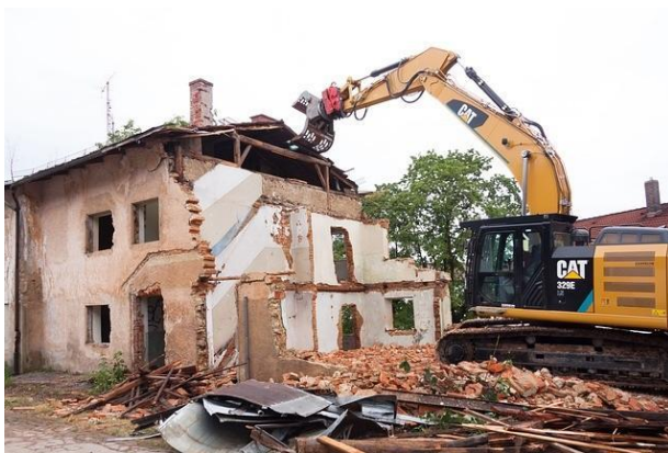
Demolición con mediante empuje
