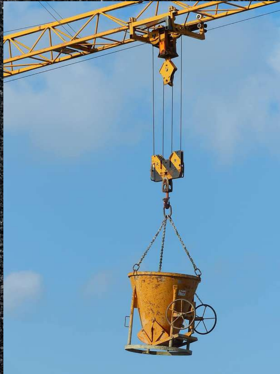
Carga de capacho para hormigonado.
