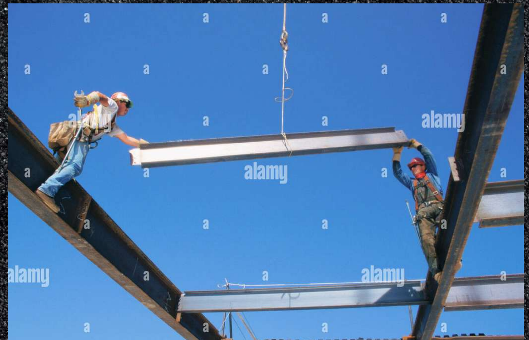
Instalación de vigas metálicas.
