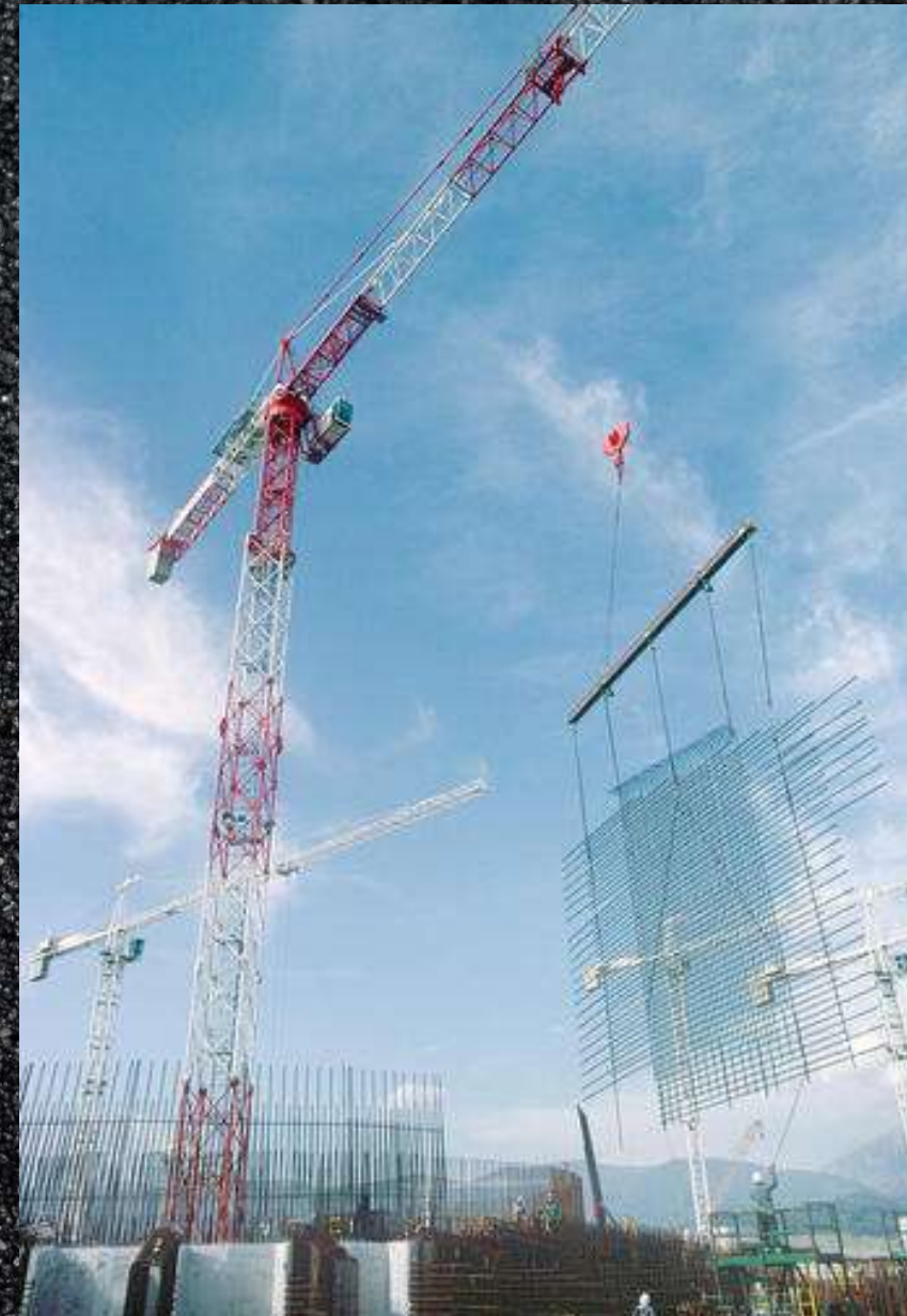
Izado de armaduras.
