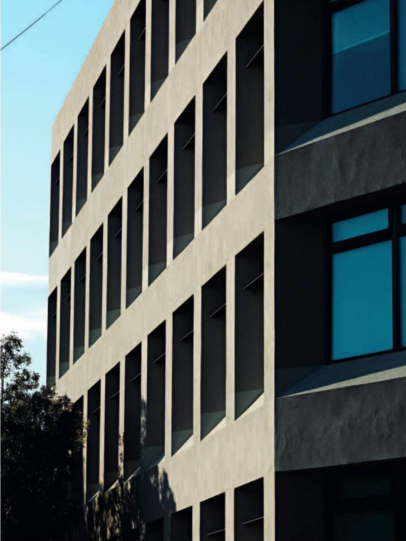
Sistema de aventanamiento en muros caracterizado según la orientación cardinal.
