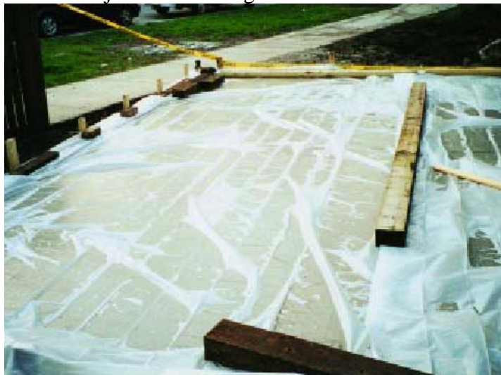
Figura 8: Curado con láminas plásticas
