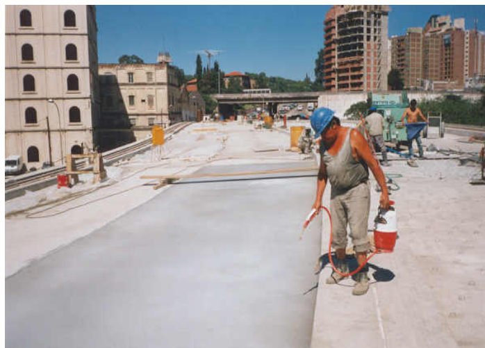
Figura 9: Aplicación de compuesto de curado
