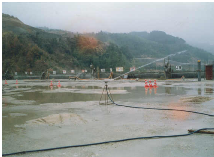
Figura 5: Curado por rociado con aspersores
