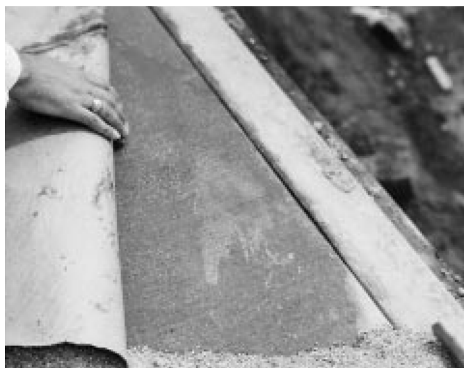
Figura 7: Curado con papel impermeable
