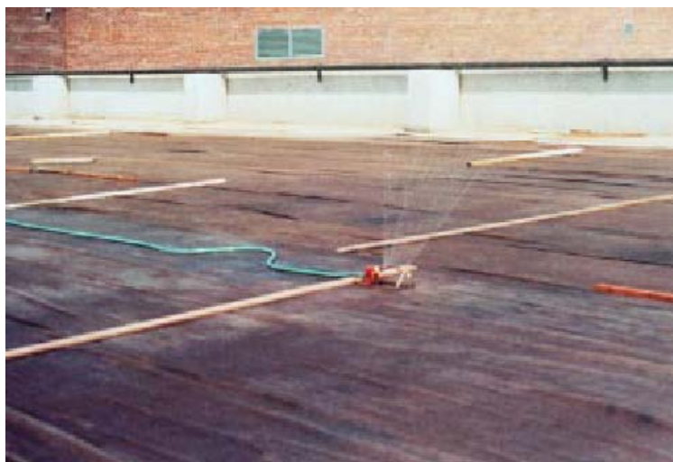
Figura 6: cobertura húmeda del hormigón
